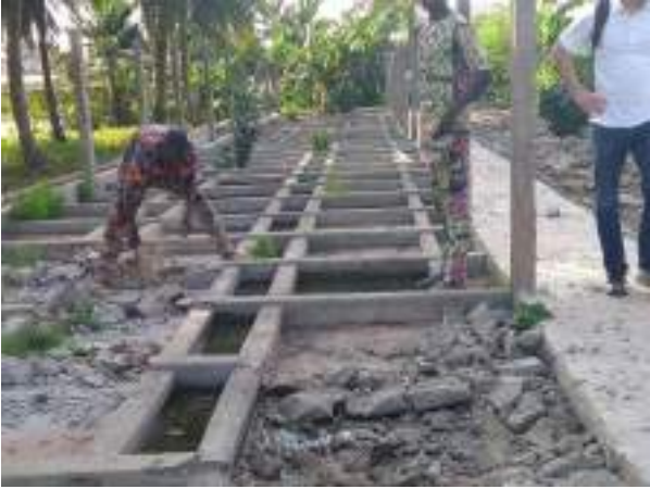
Photos de la construction du grand élevage :
