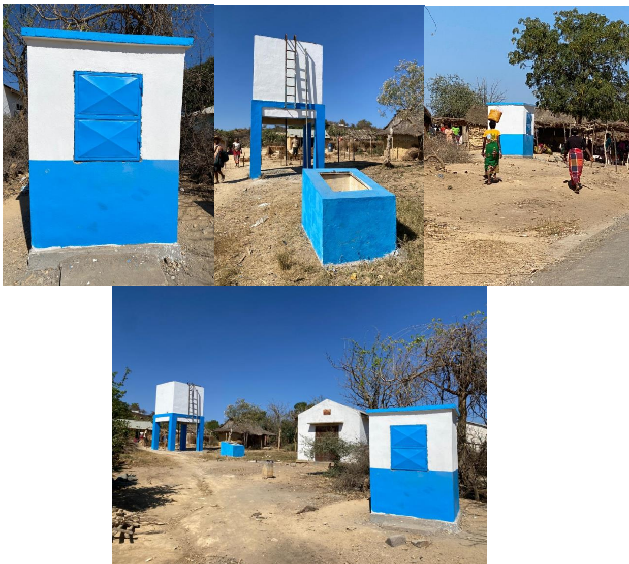
Figure IX-1 : Photos d'ouvrage AEP Vineta Andamasiny
