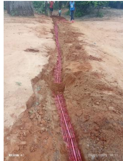
Figure VI-7 : remblais des câbles
