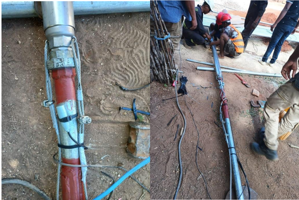
Figure VI-3 : Sécurité d'attache de la pompe
