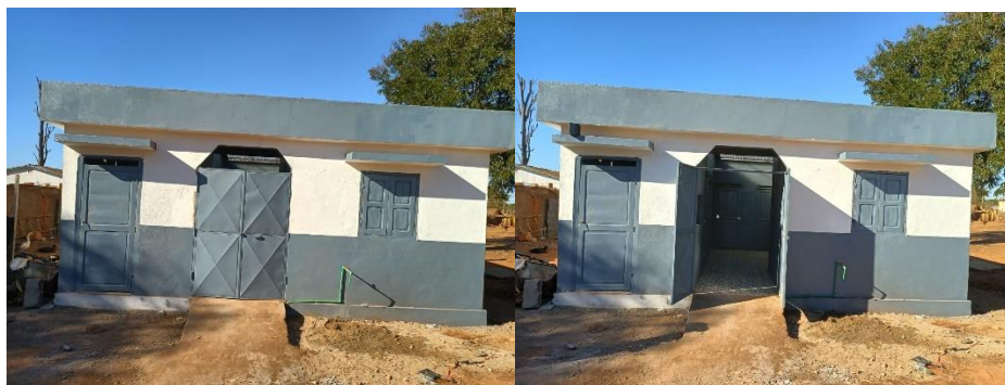
Figure VIII-1 : Photos vue de façade du bloc sanitaire Andranovory
