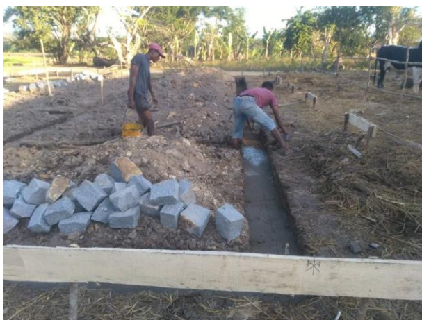
Figure 6 : Début des travaux - août 2022
