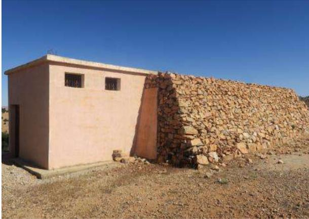
Figure 9 : Réservoir en pierres au-dessus de Nihit
