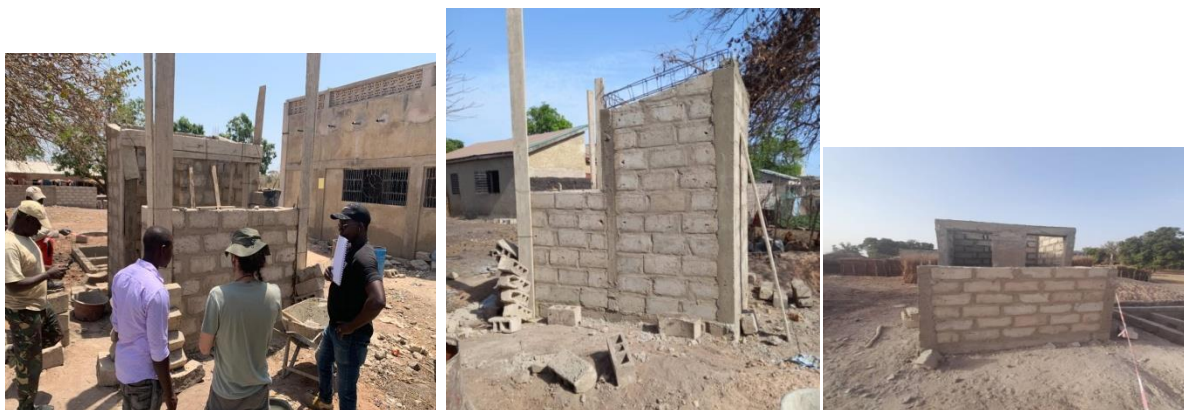
Figure 7 : état d'avancement des travaux de blocs sanitaires
