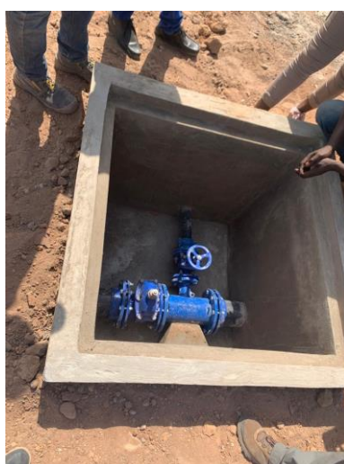
Vanne de sectionnement et té bridé
