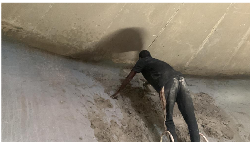
Application de l'Enduit d'étanchéité au niveau du réservoir du château d'eau
