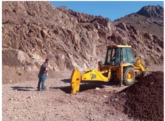
Figure 26 Creusement des puits de reconnaissance
