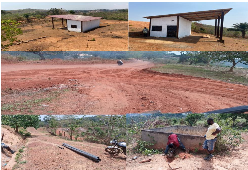
Figure 3 : Travaux de réhabilitation de la décharge de Mekwene
