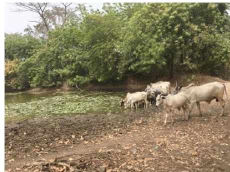
Retenue d'eau de Madengbé
