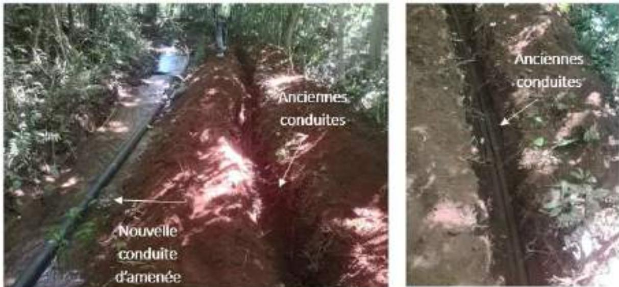
Figure 18 : nouvelle conduite d'amenée posée dans le canal et anciennes conduites lors de la dépose
