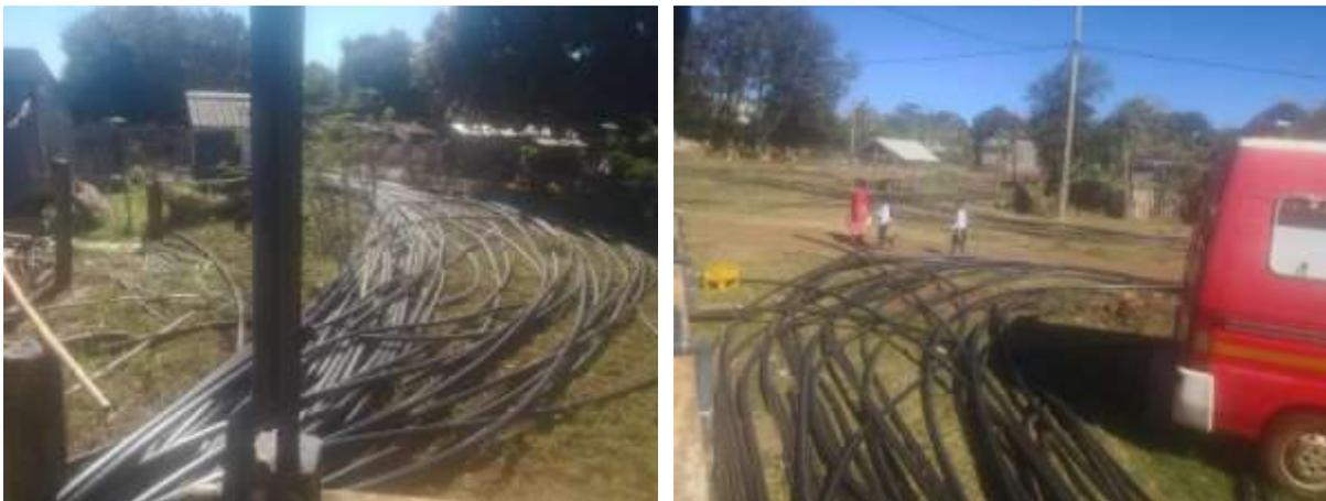
Figure 23 : Stockage des tuyaux de l'ancienne adduction déposés et stockés devant la commune avant d'être redéposés sur la distribution
