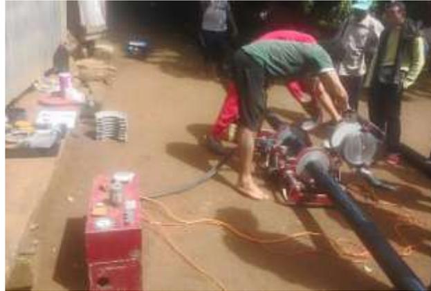
Figure 8 : électrosoudage des conduites
