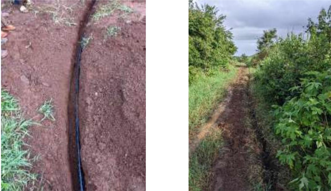
Figure 24 : Pose des tuyaux de distribution
