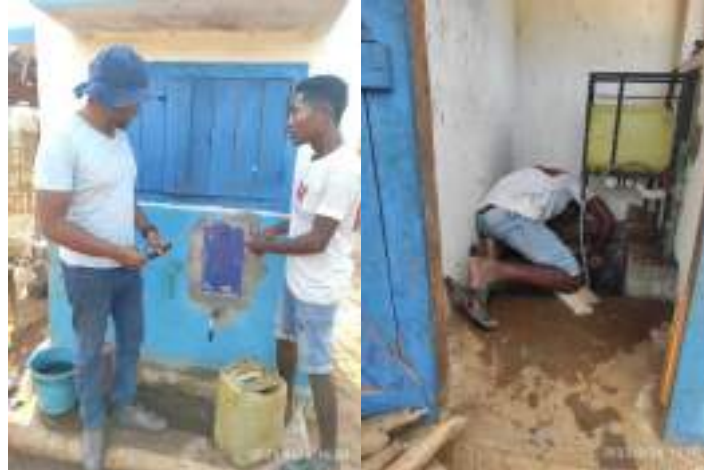
Photos du kiosque à jeton
