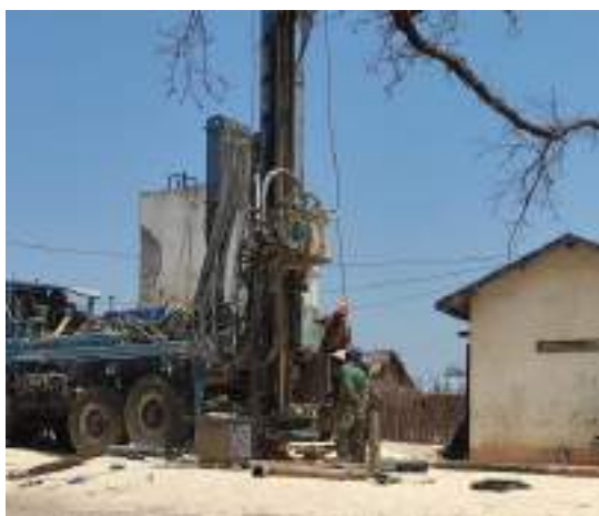
Photos du chantier forage Andranohinaly le 13/10/2023
