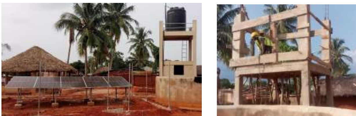
Figure 7 : Chantier de construction du PEA à Amédjrovi Kondji
