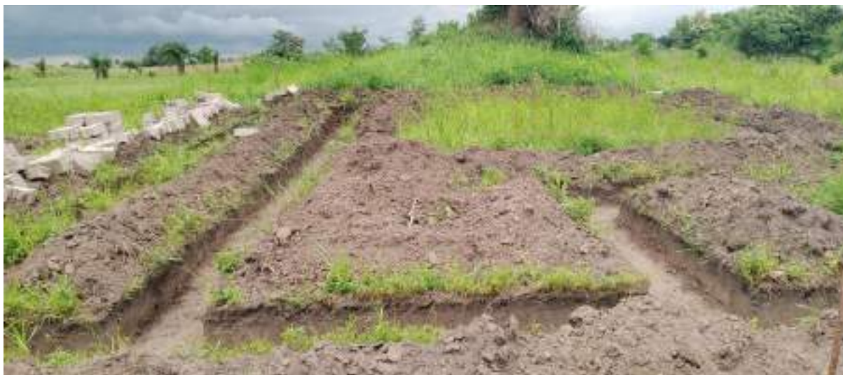
Figure 4 : Travaux réalisés sur le site abandonné du champ-école (21/06/2023)
