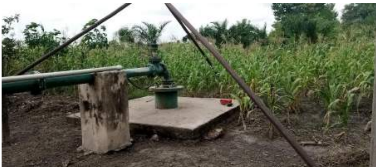
Figure 5 : La tête de forage de F1 est située à proximité directe de cultures de maïs où sont potentiellement épandus des engrais et pesticides chimiques (01/07/2023)
