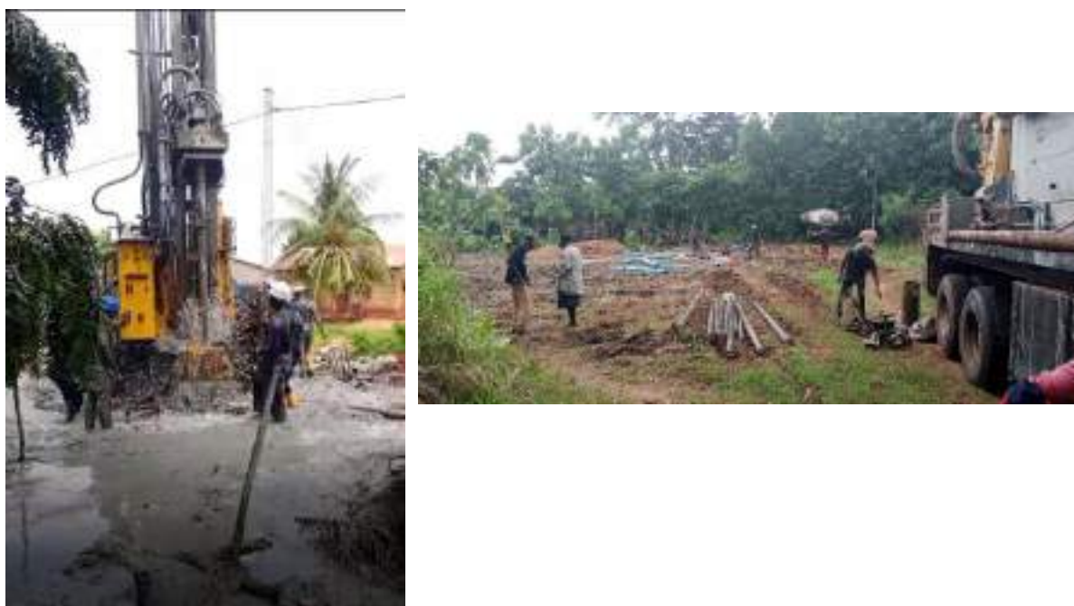
Figure 6 : Réalisation du forage (gauche) et chantier de foration (droite) à Toudji Kondji
