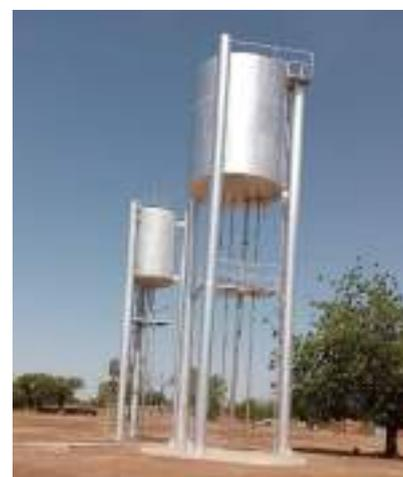
Le château d'eau est constitué d'une cuve de forme cylindro-conique et trois (03) poteaux cylindriques. La cuve est constituée :
