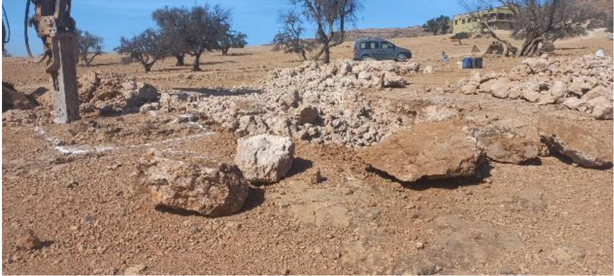
Figure 15 : Traçage et terrassement de la STEP de Taguant
