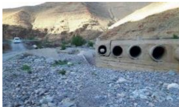
Figure 22 : Photographies de l'ouvrage de franchissement détruit
