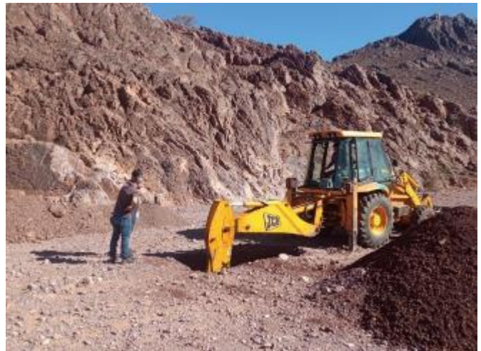
Figure 27 : Creusement des puits de reconnaissance
