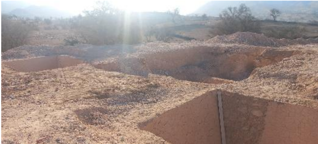
Figure 17 : Finition des bassins des filtres et de sable
