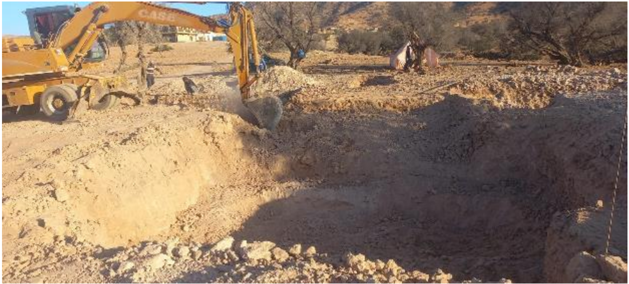
Figure 16 : Terrassement du lit de filtration de la STEP de Taguant
