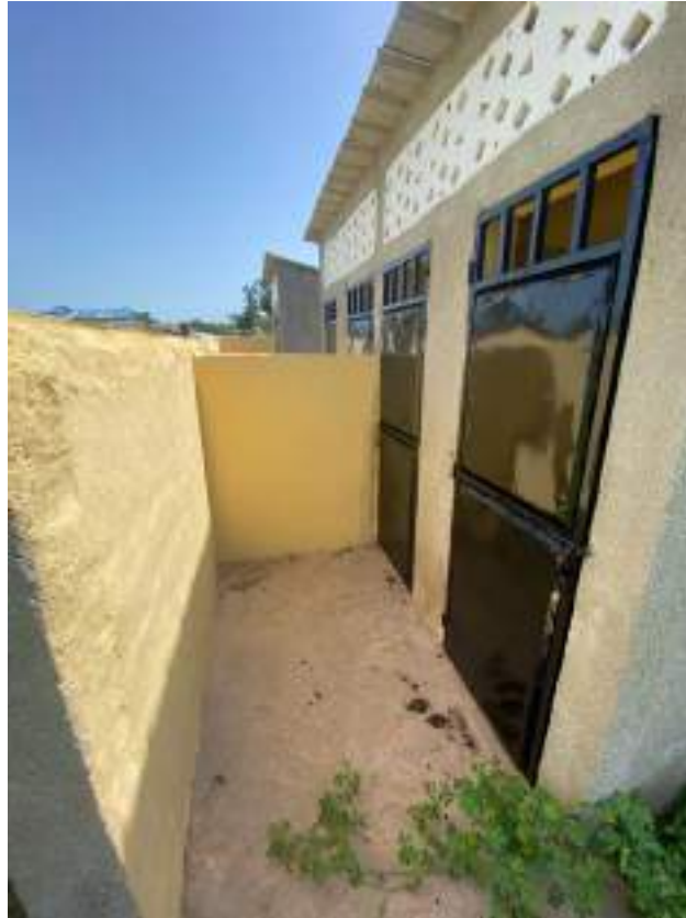
Toilette école élémentaire Némataba réhabilitée
