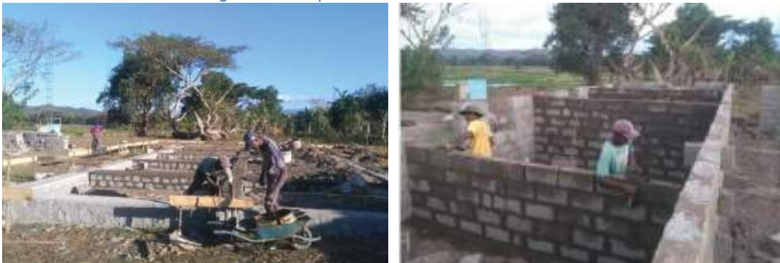
Figure 9 : Construction en cours
