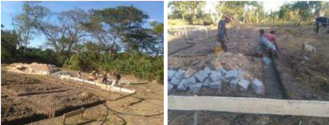
Figure 8 : Photos prises au début des travaux - août 2022
