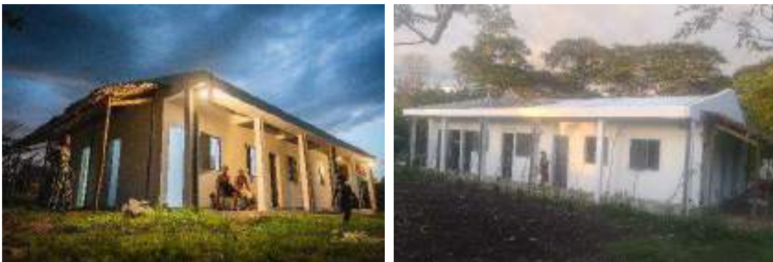
Figure 10 : Photos prises à la mise en services – avril 2023
