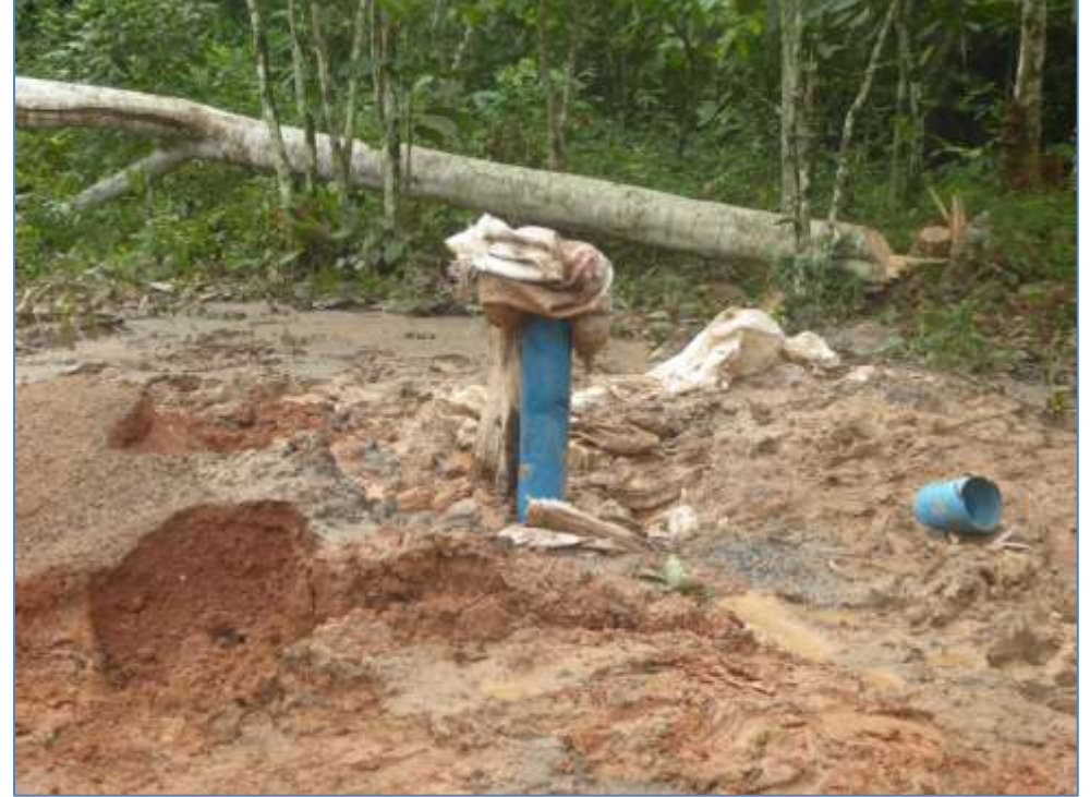
Ici, scellés des forages entièrement équipés dans les villages Angon (Aboa) et Bikoglo-Bikome, et en attente des essais de pompage et de détermination des caractéristiques des forages © Projet MODEAME-Mbankomo
