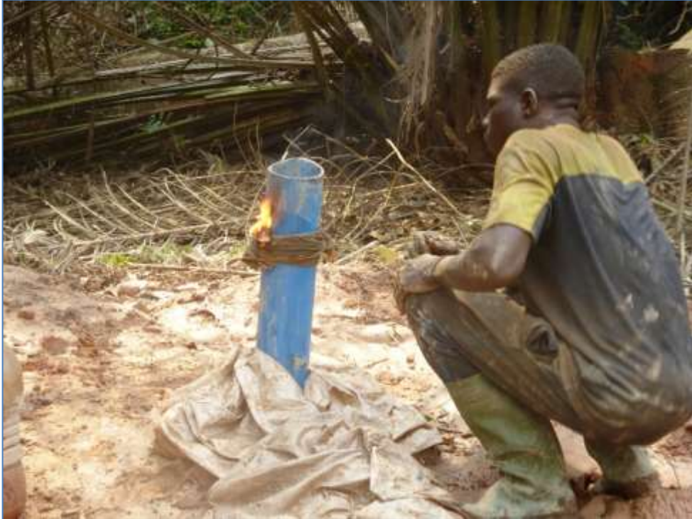
Ici, scellés des forages entièrement équipés dans les villages Angon (Aboa) et Bikoglo-Bikome, et en attente des essais de pompage et de détermination des caractéristiques des forages © Projet MODEAME-Mbankomo
