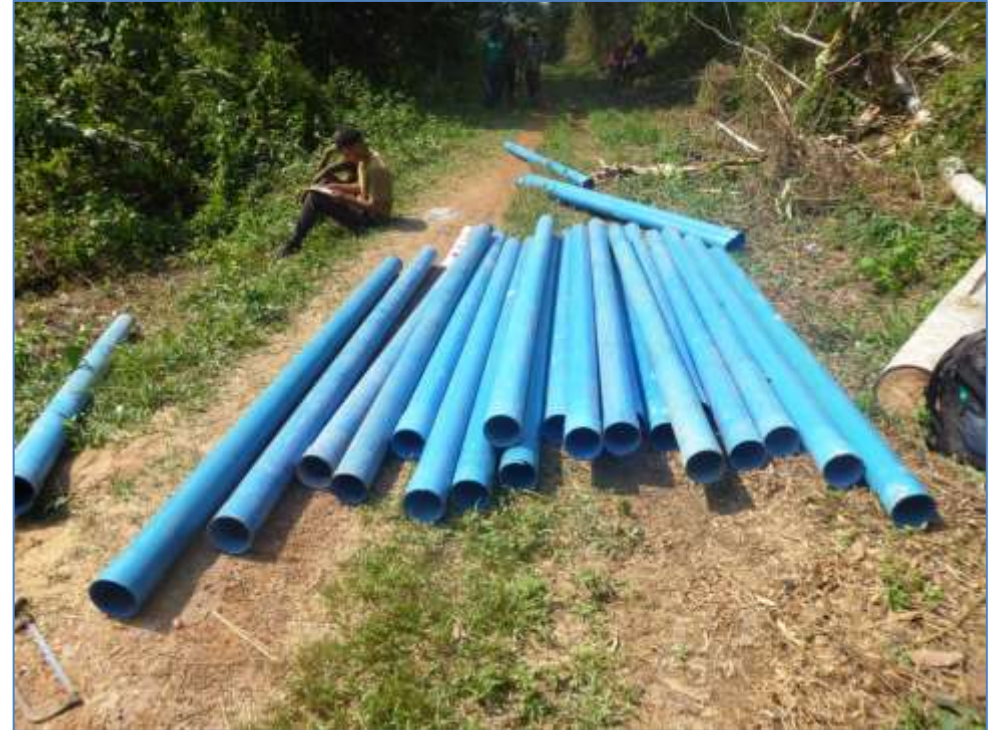
Ici, pose des tubes provisoires en acier (késine) et tuyaux PVC pleins et crépines Ø125 mm lors de l'équipement du forage d'Angon (Aboa) Foration – Équipement – Nettoyage du forage – Essai de pompage – Installation de la pompe © Projet MODEAME-Mbankomo
