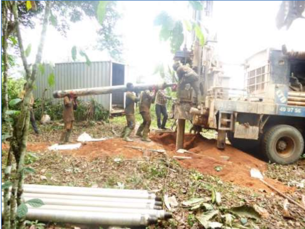
Ici, pose des tubes provisoires en acier (késine) et tuyaux PVC pleins et crépines Ø125 mm lors de l'équipement du forage d'Angon (Aboa) Foration – Équipement – Nettoyage du forage – Essai de pompage – Installation de la pompe © Projet MODEAME-Mbankomo
