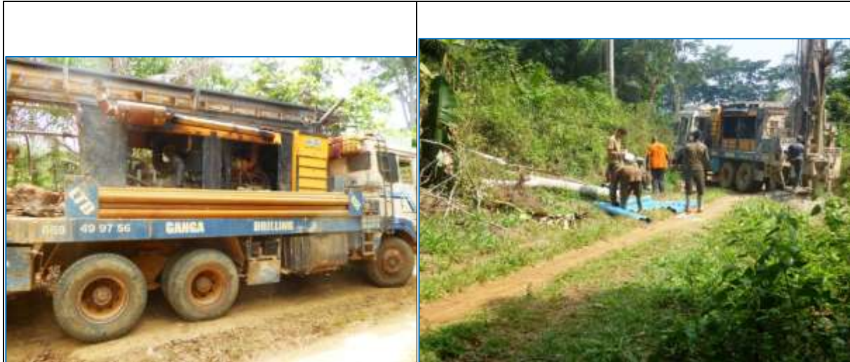
Atelier de forage (GANGA Drilling Arl) affrété par les Ets Menye & Fils dans le cadre des travaux
