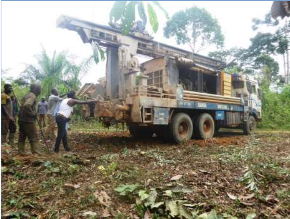
Ici, arrivée et installation de l'atelier de forage dans le village Bikoglo-Bikome © Projet MODEAME-Mbankomo
