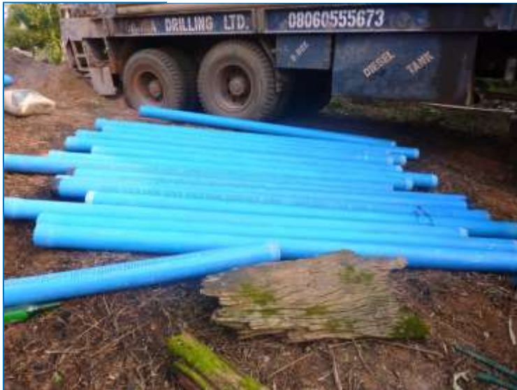
Tuyaux PVC pleins et crépinés, & massif filtrant calibré utilisés pour l'équipement des forages
