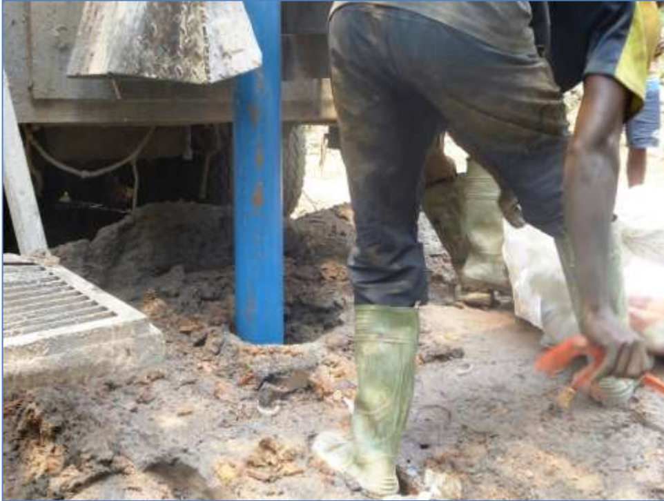
Ici, pose des tuyaux PVC et du massif filtrant dans le forage en construction de Bibong-Bidoum © Projet MODEAME-Mbankomo
