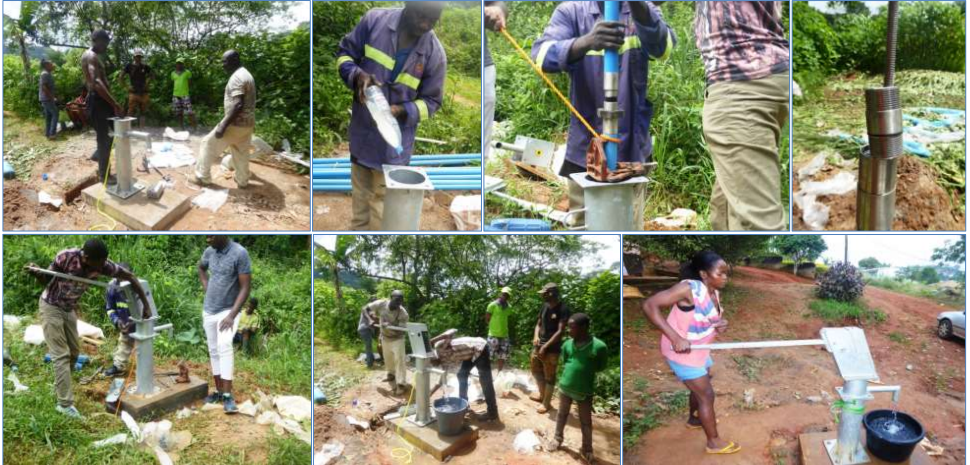
Quelques clichés pris lors de l'installation des PMH dans les sites de Nkol-Ntsam, Bikoglo-Bikome, Etil-Bibegue, Zouassel, Mbankomo-Centre © Projet MODEAME-Mbankomo
