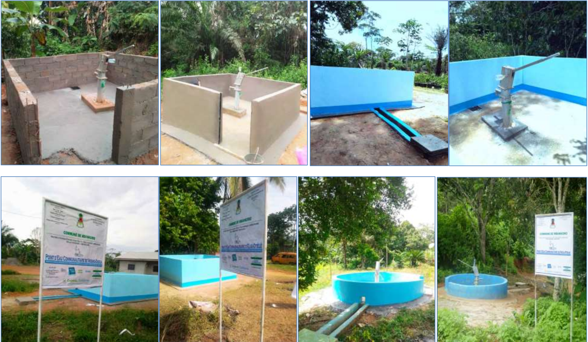
Quelques clichés sur les étapes de construction des superstructures (muret de protection, margelle, canal d'évacuation des eaux usées, puits perdu, anti-bourbier, etc.)
