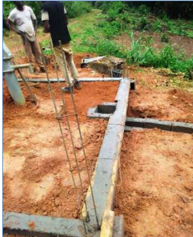
Quelques clichés sur les étapes de construction des superstructures (muret de protection, margelle, canal d'évacuation des eaux usées, puits perdu, anti-bourbier, etc.) © Projet MODEAME – Mbankomo
