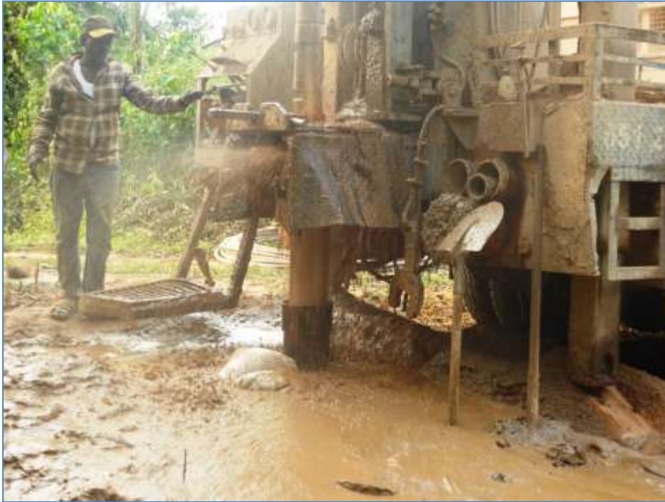
Ici, jaillissement de l'eau dans le village Zouassel © Projet MODEAME-Mbankomo
