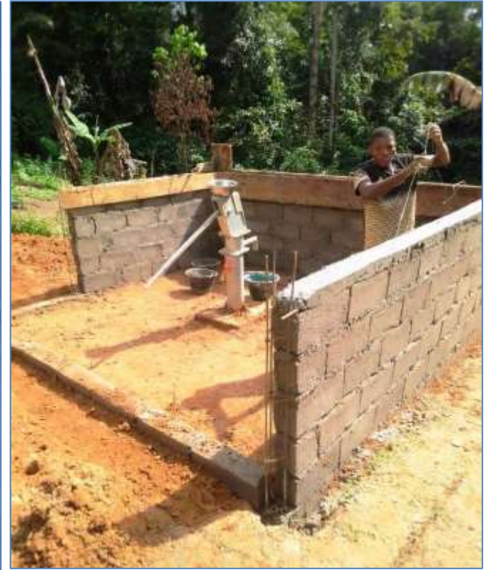
Quelques clichés sur les étapes de construction des superstructures (muret de protection, margelle, canal d'évacuation des eaux usées, puits perdu, anti-bourbier, etc.) © Projet MODEAME – Mbankomo
