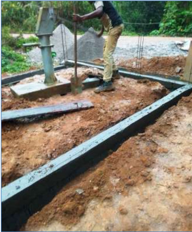
Quelques clichés sur les étapes de construction des superstructures (muret de protection, margelle, canal d'évacuation des eaux usées, puits perdu, anti-bourbier, etc.) © Projet MODEAME – Mbankomo
