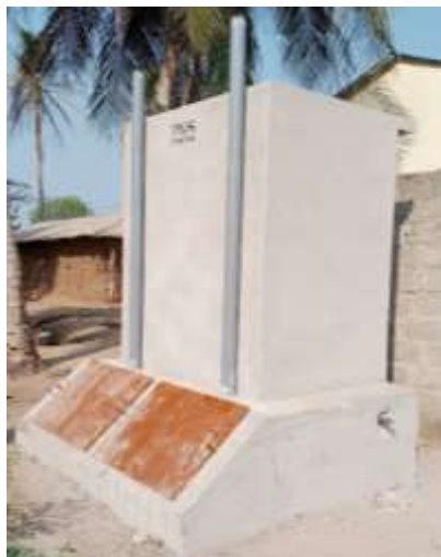
Figure 20. Exemple d'une latrine ECOSAN en cours de construction (gauche) et réceptionnée (droite) à Sikakondji.
