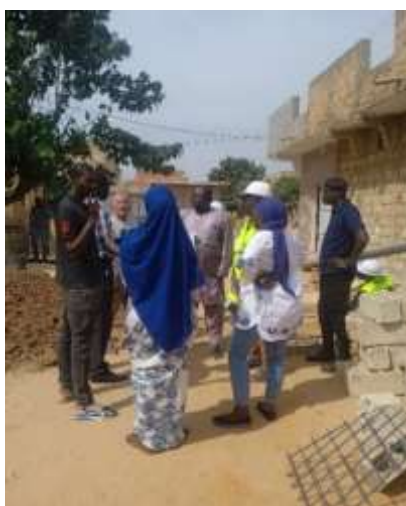
FIGURE 21: VISITE DE LA MAIRIE LE PREMIER JOUR DU CHANTIER
