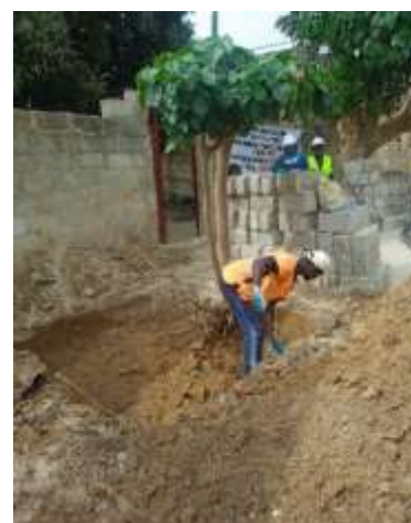
FIGURE 12: J1 DU CHANTIER ECOLE. LE FOSSEYEUR ENTAME LA FOSSE DU PUISARD SEMI-COLLECTIF. CELA LUI PRENDRA LA JOURNEE DE CREUSER UNE FOSSE DE 2X2M
