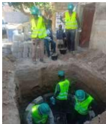
FIGURE 13: CONSTRUCTION DU PUISARD EN EQUIPE
