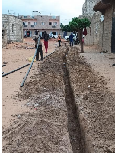
Pose des conduites phase I
