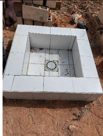
Dimensions intérieures du déversoir: L 70 cm x l 70 cm x P 30 cm
