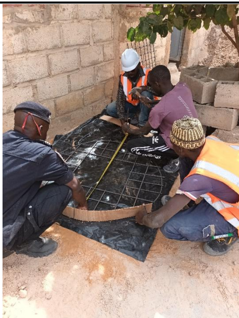
Construction du couvercle du puit
