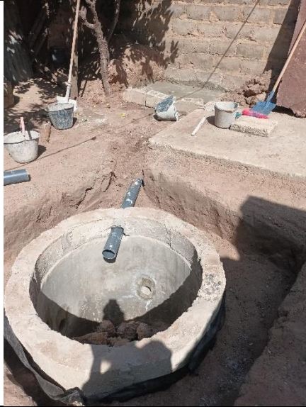
Coulage du chaînage du puit et raccord tuyau pv entre le puit et le déversoir
