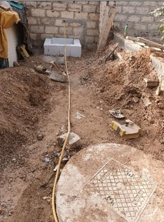
Dimensions intérieures du déversoir: L 82 cm x l 67 cm x P 30 cm
