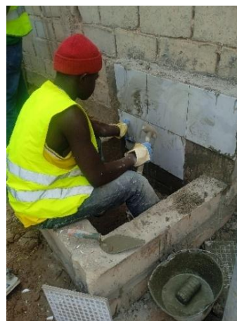
Carrelage du déversoir
