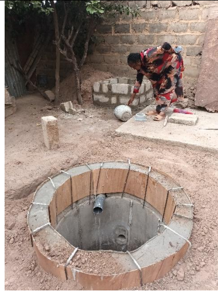
Construction du déversoir
