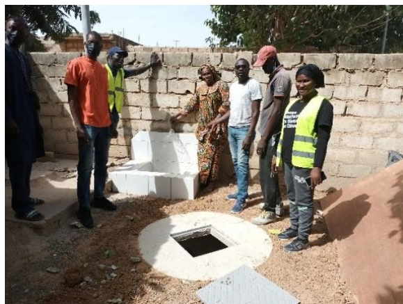
Visite des 18 puisards par l'agent voyer de la Mairie de Mbour
