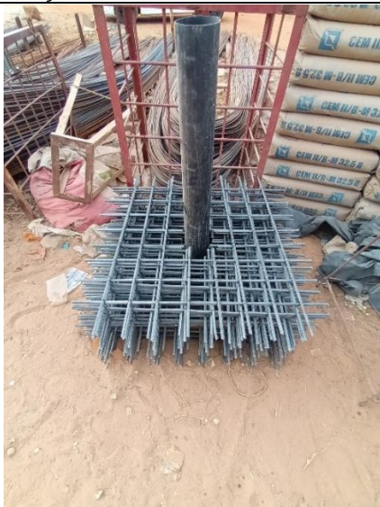
Ferrailage des semelles par le quincailler
