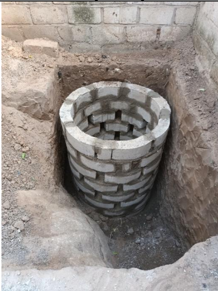
Maconnerie d'un puit individuel à côté de la roche (Yacine Sarr)
