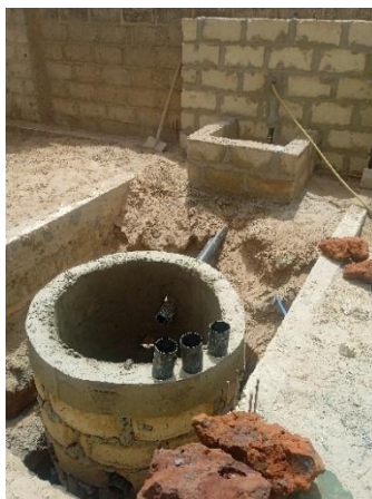
Puisards en construction
