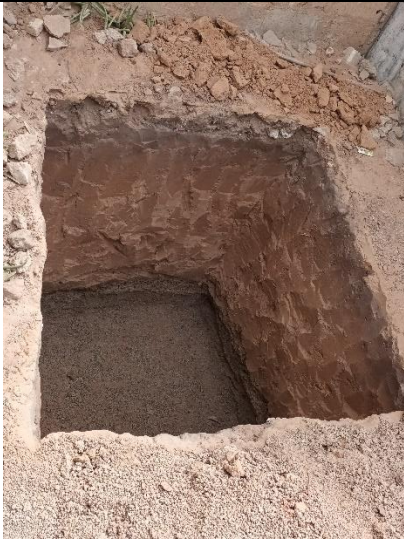
Fouille de 2 m de profondeur et 2 mètres de large
