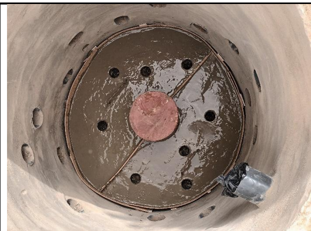
Coulage du massif filtrant du puitsard
