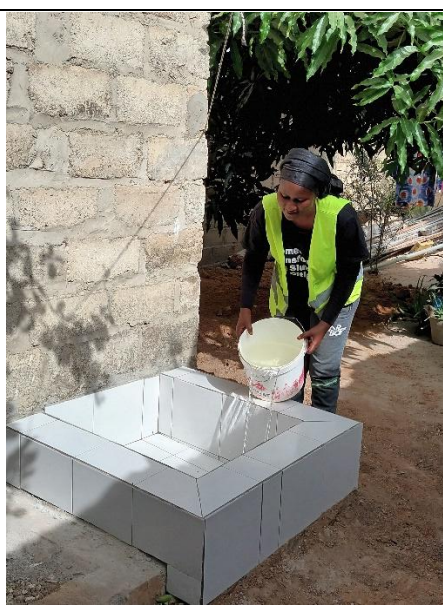
Test d'écoulement de l'eau dans le déversoir vers le puit
