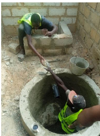
Puit avec roche apparente, bétonnage entre la roche et la paroi du puits
