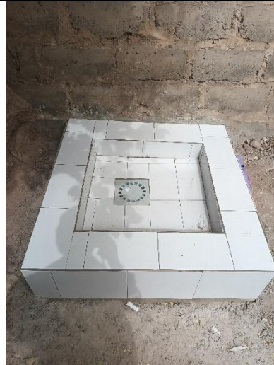
Dimensions intérieures du déversoir: L 70 cm x l 70 cm x P 18 cm
