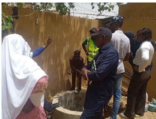
Figure 12 : Visite à mi-chantier des représentants
