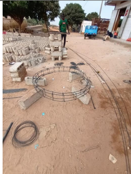
Ferrailage de la couronne d'un puit par le quincailler
