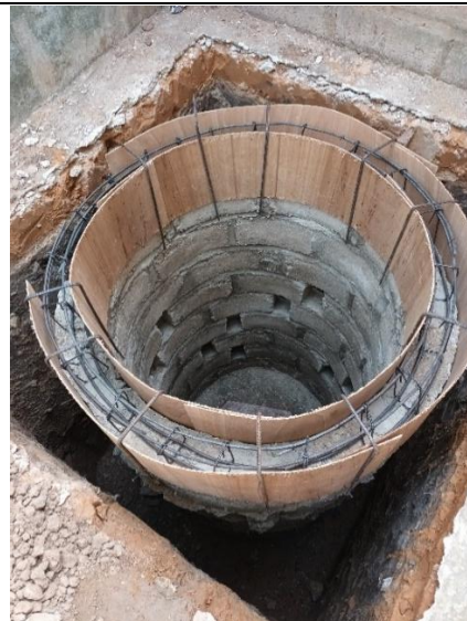
Chainage d'un puit
