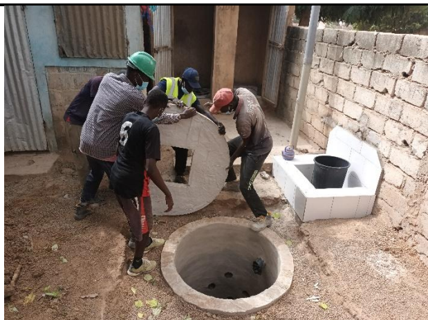
Pose du couvercle sur le puit
