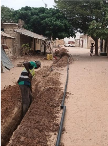
Terrassement en phase I (à gauche) et en phase II des travaux (à droite)
