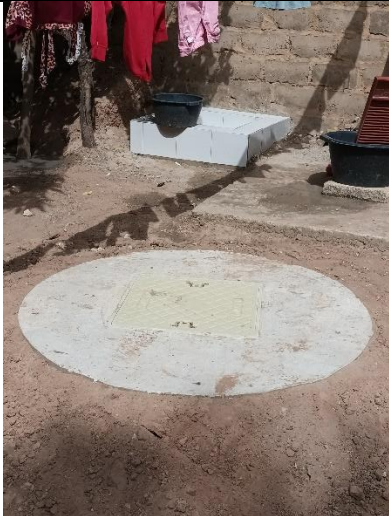
Dimensions intérieures du déversoir: L 70 cm x l 70 cm x P 18 cm
