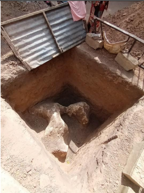
Roche rencontrée lors d'une fouille
