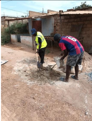
Confection du mortier pour le puit
