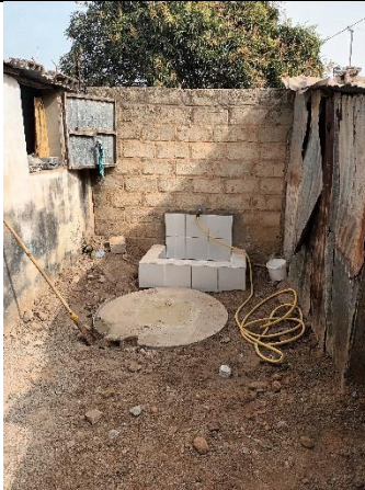
Dimensions intérieures du déversoir: L 86 cm x l 56 cm x P 30 cm
