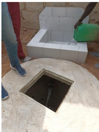
Test d'écoulement de l'eau du déversoir au puit dans deux puisards
