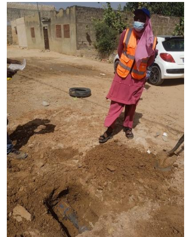
Sondage vers le raccordement au réseau phase II
