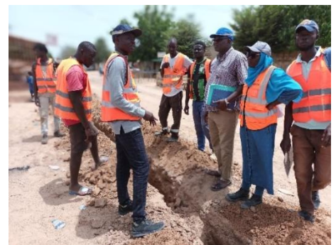
Visite de la Direction Générale de la SEN'EAU sur le chantier
