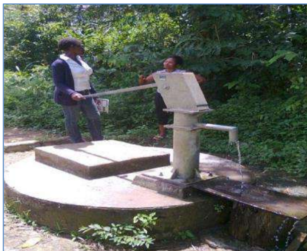
Puits avec PMH dans le village AKOATALA construit par le BIP-MINEE en 2019 © AUNTD 2023
