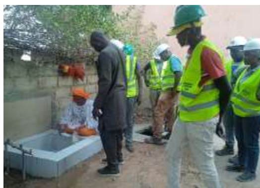
FIGURE 20: RECEPTION DU PUISARD INDIVIDUEL (N°1) PAR LA BENEFICIAIRE EN PRESENCE DU DIRECTEUR D'URBASEN ET DE L'EQUIPE DU CHANTIER ECOLE.
