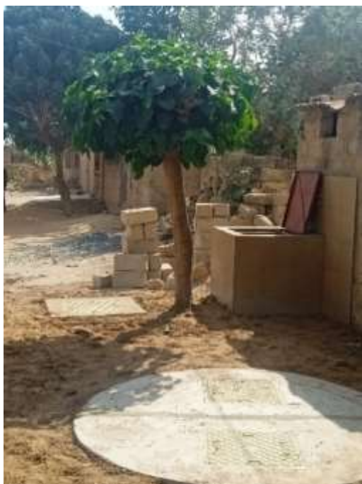
FIGURE 17: PUISARD SEMI COLLECTIF CONSTRUIT PAR LE CHANTIER ECOLE
