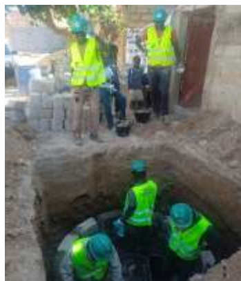
FIGURE 13: CONSTRUCTION DU PUISARD EN EQUIPE
