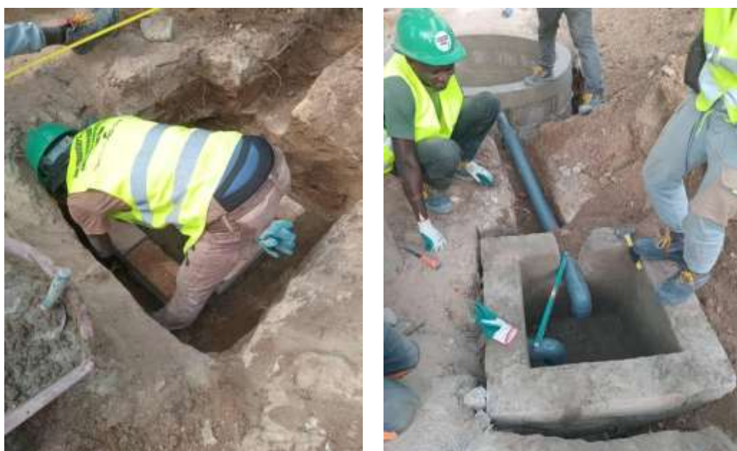
FIGURE 15: FOUILLE DU DECANTEUR (A GAUCHE) ET CONSTRUCTION DU DECANTEUR (A DROITE)
