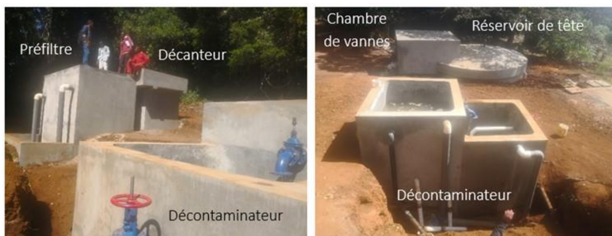
Figure 12 : photos de l'unité de traitement et stockage prises mi-juin (réception technique)
