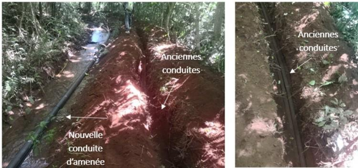
Figure 20 : nouvelle conduite d'amenée posée dans le canal et anciennes conduites lors de la dépose
