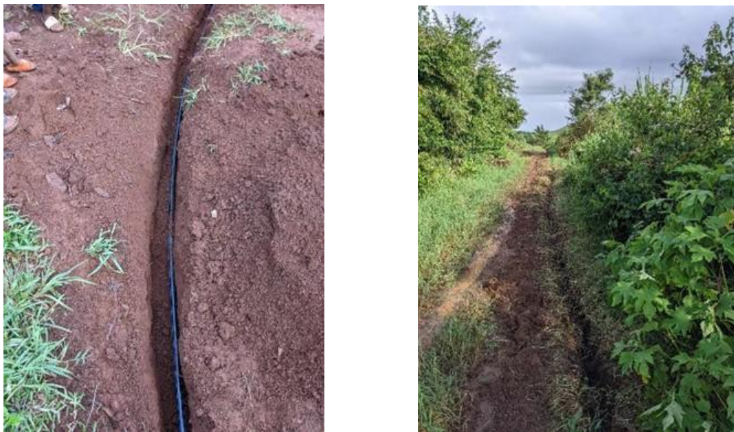
Figure 26 : Pose des tuyaux de distribution
