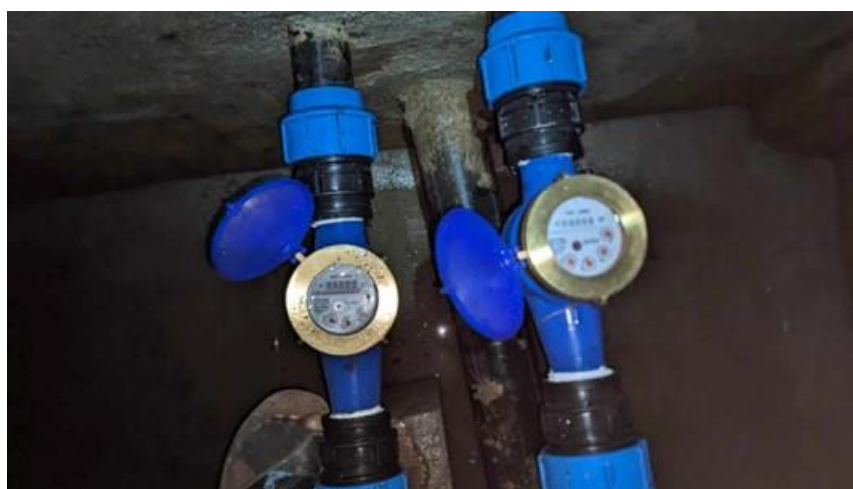
Figure 37 : ajout de deux nouveaux compteurs sur l'arrivée d'eau brute
