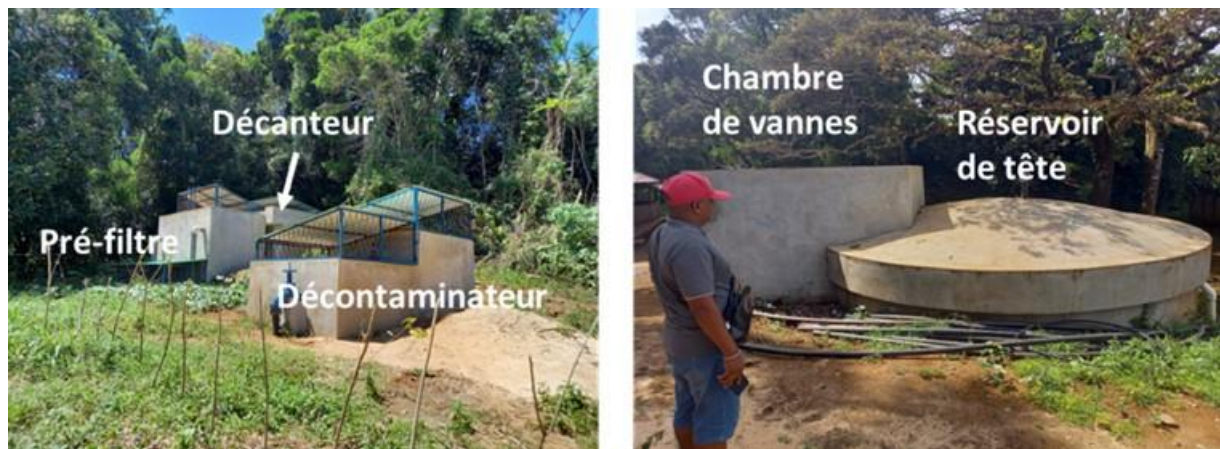
Figure 13 : photos de l'unité de traitement et stockage prises en décembre 2023
