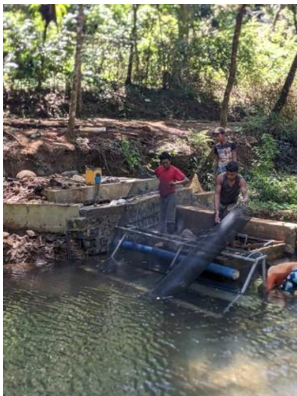
Figure 36 : ventouse ajoutée sur la conduite d'amenée pour permettre l'évacuation de l'air dans la conduite et augmenter le débit d'eau brute qui arrive à la station de traitement
