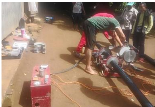
Figure 10 : électro soudage des conduites
