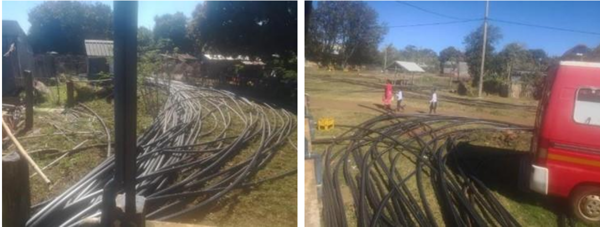
Figure 25 : Stockage des tuyaux de l'ancienne adduction déposés et stockés devant la commune avant d'être redéposés sur la distribution
