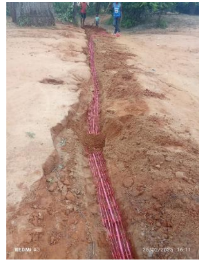
Figure V-9 : remblais des câbles
