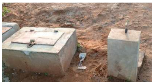
Figure 2 : Photos des niches de Branchements privés
