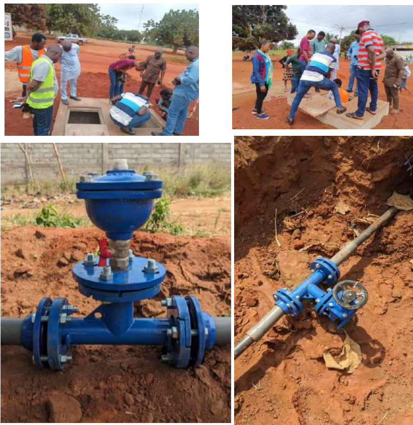
Figure 1 : Travaux de sectorisation sur le réseau d'eau potable de MTK
