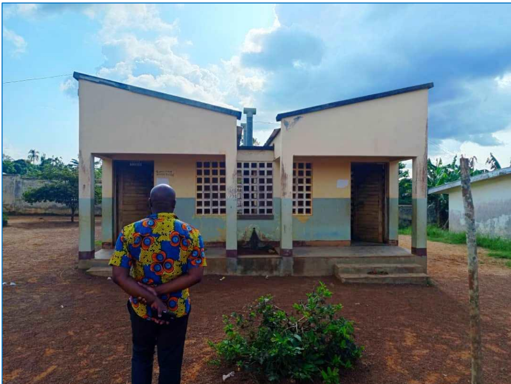
L'entrepreneur devant le modèle de latrine à construire à Ngoulemakong ® AUNTD 2025
