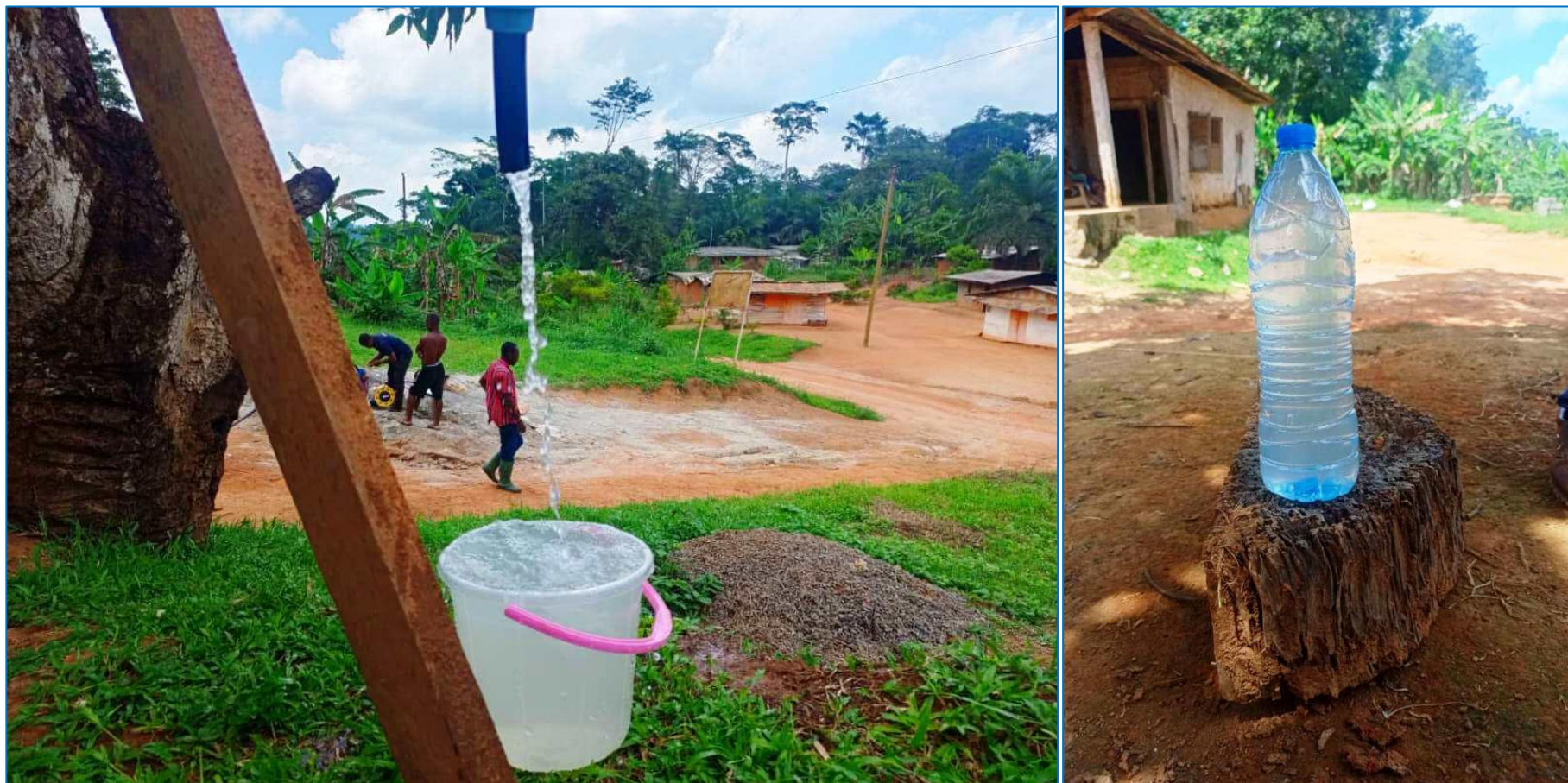
L'ingénieur hydraulicien de l'entreprise adjudicataire durant les opérations des essais de pompage à MBENG © AUNTD 2025
