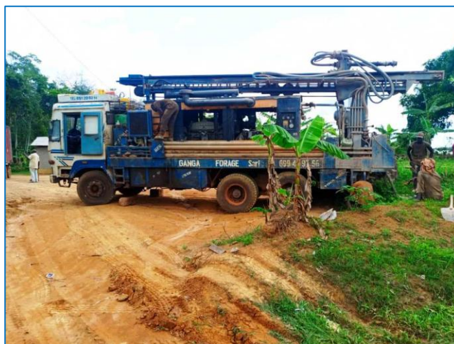
Réalisation du forage de la mini-PEA de MBENG
