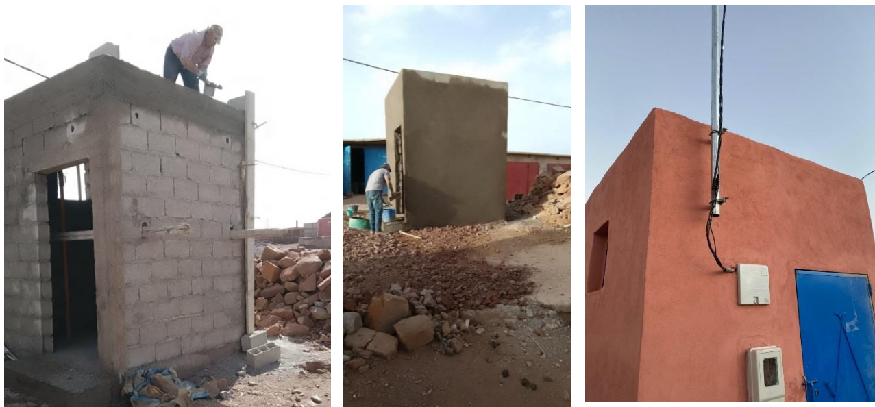
Figure 6 Travaux de construction du local surpresseurs
