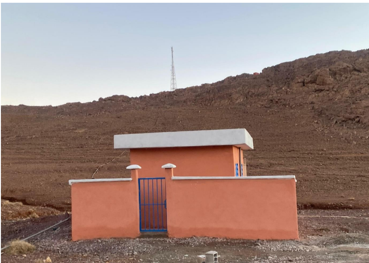
Figure 14 Local technique d'Ibakizen après la fin des travaux
