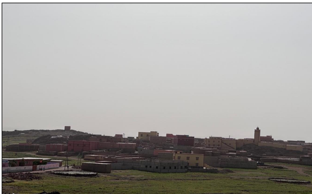
Figure 1 Vue panoramique du douar Ibakizen
