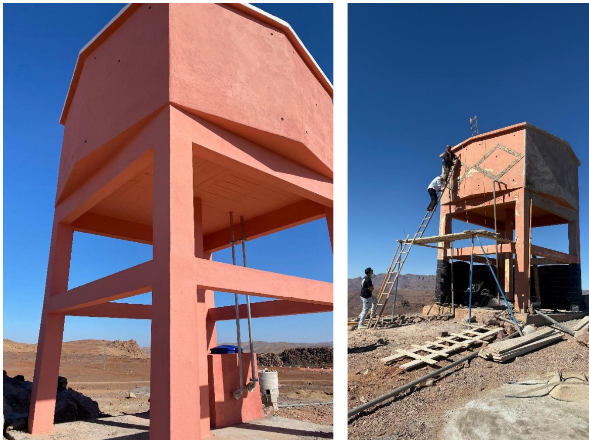
Figure 8 Réservoir RES1 en cours et après les travaux
