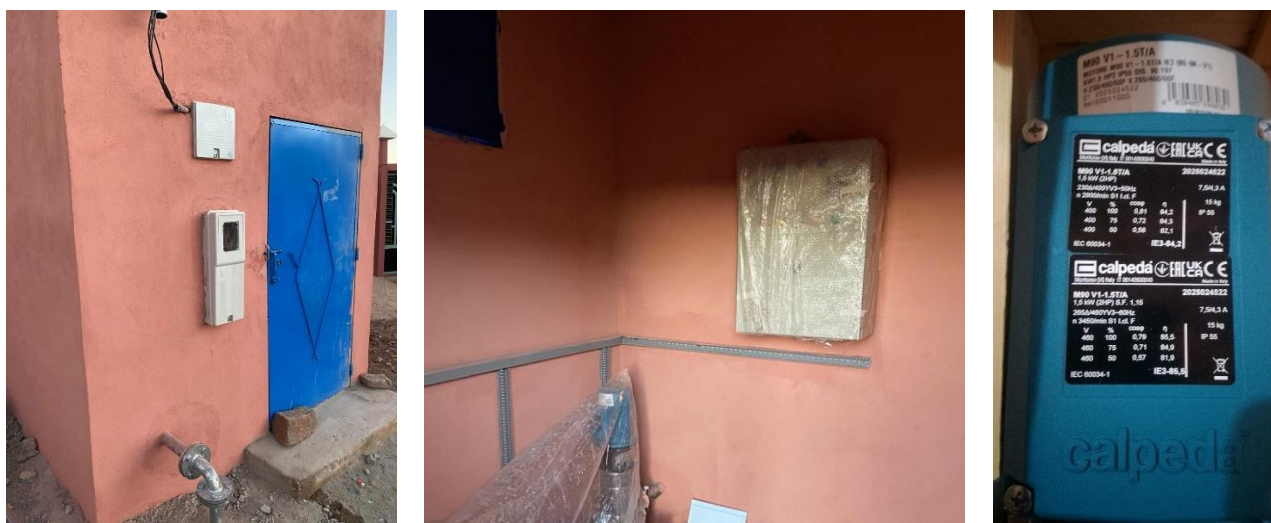
Figure 7 Travaux d'équipement du local surpresseur
