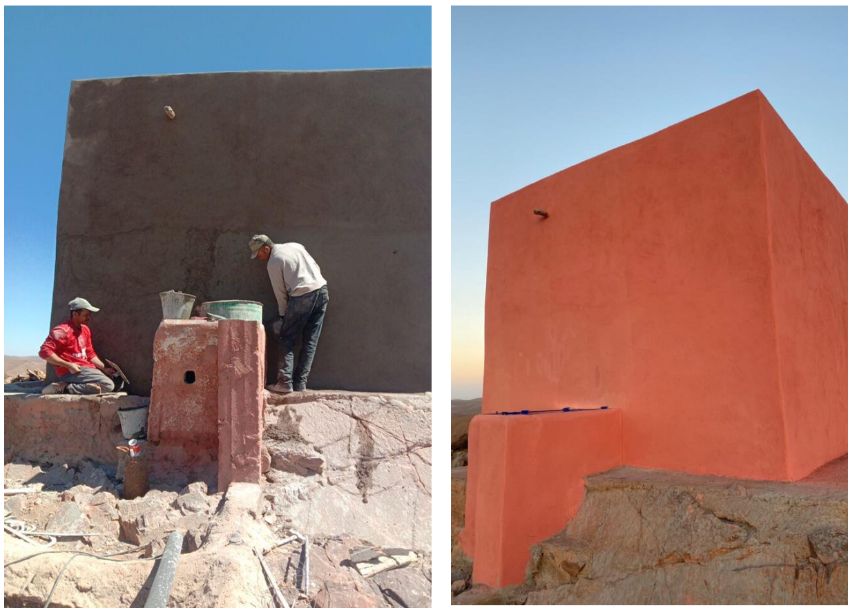
Figure 9 Réservoir RES2 en cours et après les travaux
