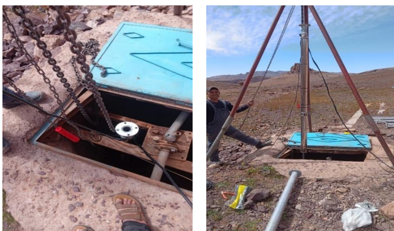
Figure 12 Opération de descente de la nouvelle pompe
