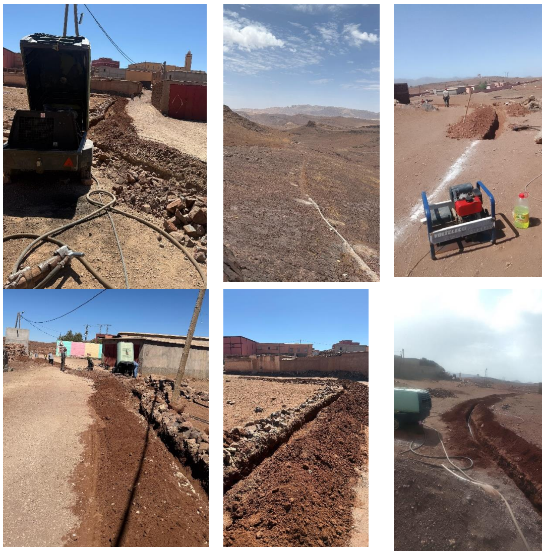
Figure 5 Travaux de pose des conduites
