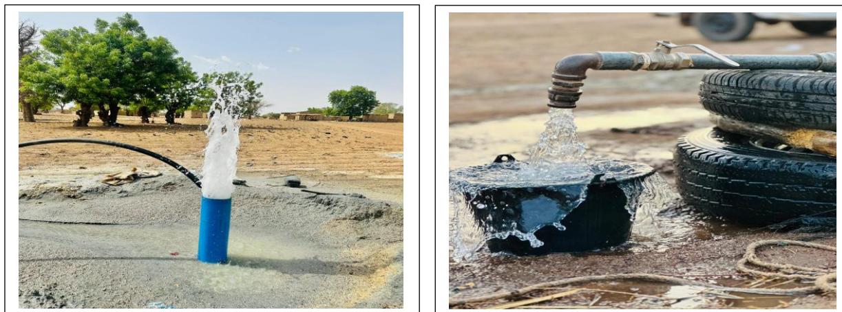
Figure 12 : Essais de pompage sur le forage F4 (nouveau forage : mai 2025)
