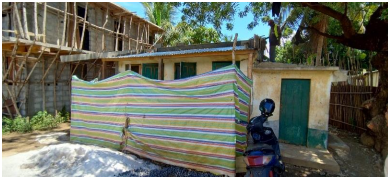
Figure 7 : Site de SCAMA Nord (Réhabilitation du bloc supplémentaire) - Mars 2026
