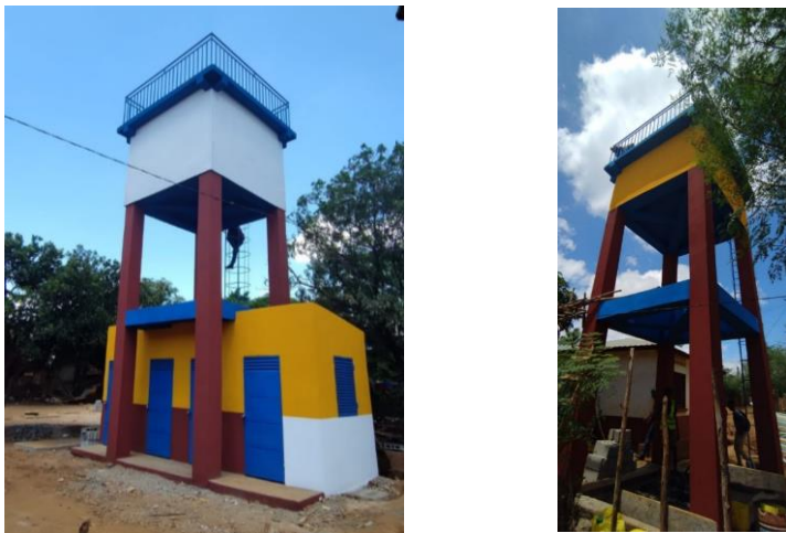
Figure 3. Site d'Ambalakazaha (gauche) et site de Cité ouvrière (droite) - Mars 2026
