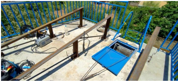
Figure 9: Structures de support PV en cours d'installation sur le site de SCAMA Sud - Mars 2026
