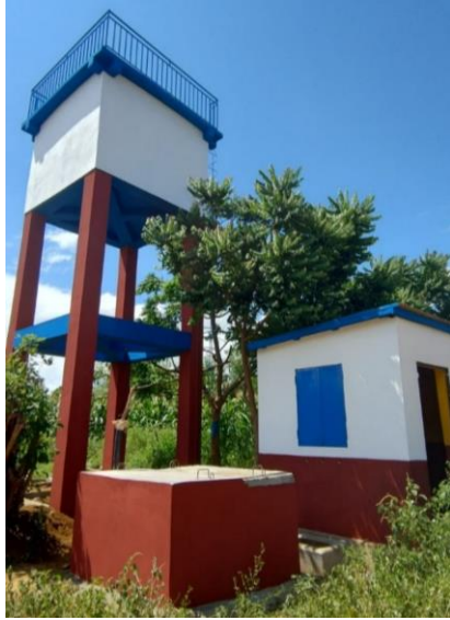
Figure 6 : Site de SCAMA Sud (réservoir, forage et kiosque de distribution) - Mars 2026
