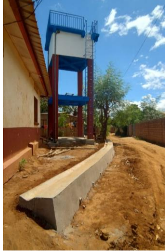
Figure 8: Site de Cité Ouvrière (Ouvrage de protection contre l'érosion) – Mars 2026
