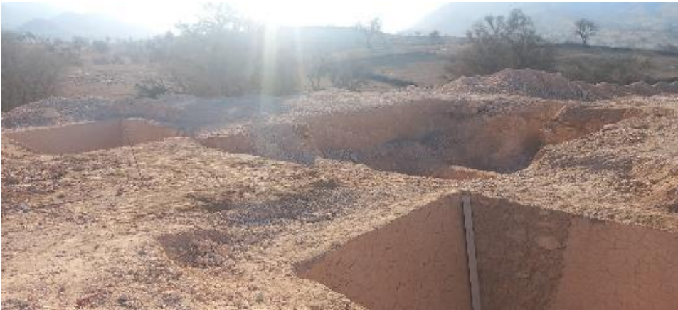
Figure 15 : Finition des bassins des filtres et de sable
