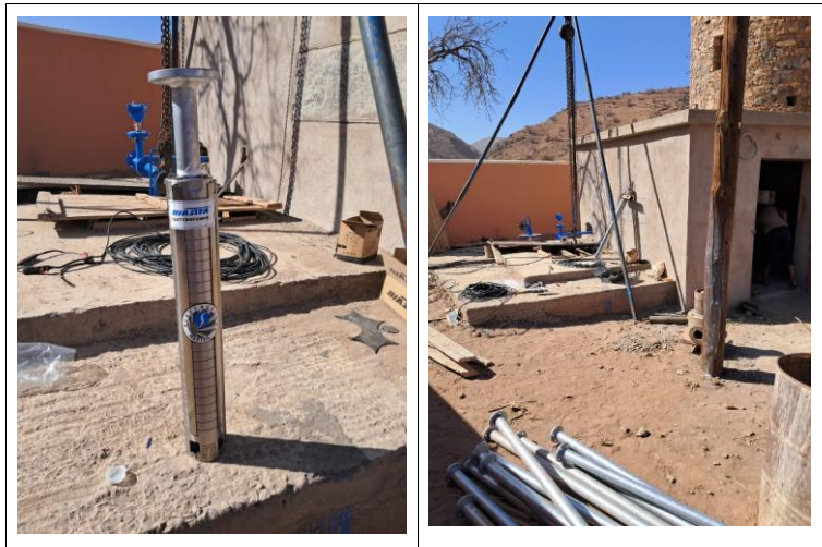
Figure 33 Installation de la pompe immergée du douar
