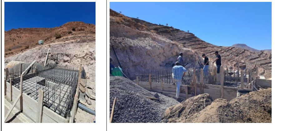
Figure 28 Réception du ferrailage du radier
