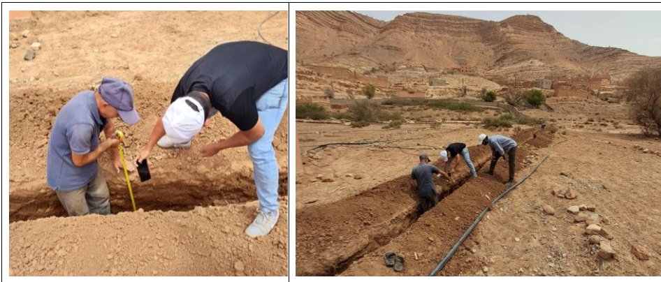
Figure 25 Travaux de pose du réseau de refoulement
