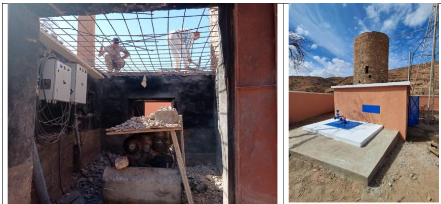
Figure 32 Local de pompage en cours des travaux et après l'achèvement
