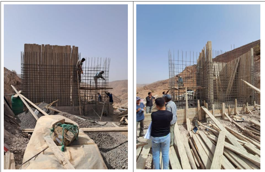
Figure 29 Réception du ferrailage du voile
