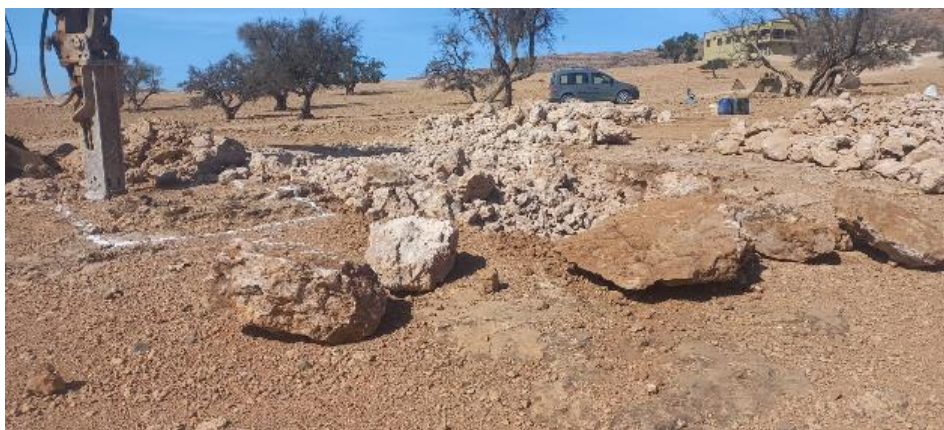
Figure 13 : Traçage et terrassement de la STEP de Taguant
