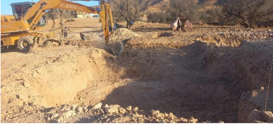
Figure 14 : Terrassement du lit de filtration de la STEP de Taguant
