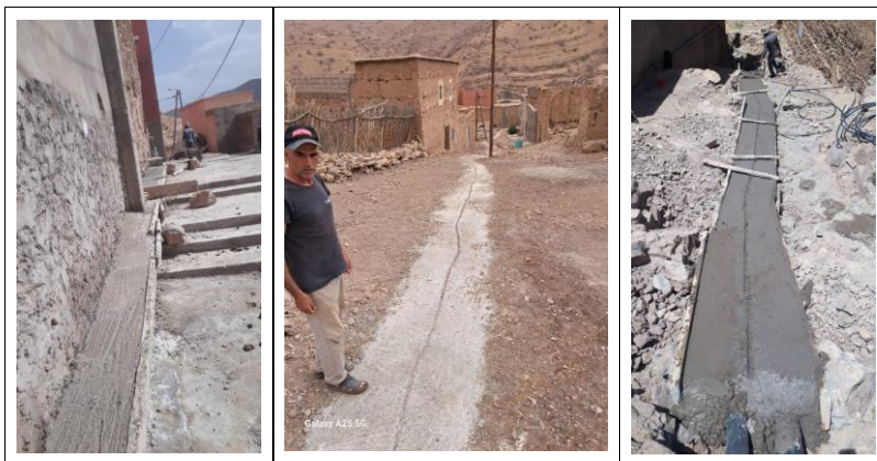
Figure 27 Pose du réseau de distribution
