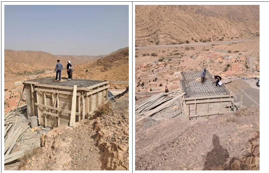
Figure 30 Réception du ferrailage de la dalle
