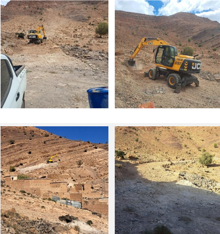
Figure 23 Travaux de terrassement
