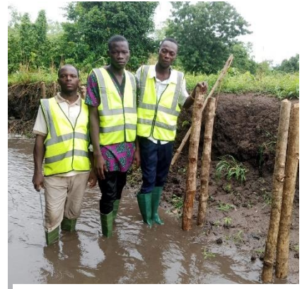
Figure 1 : Installation des fascines
